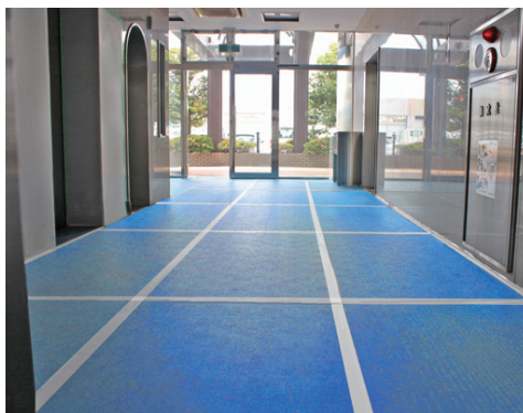
養生シート設置例
