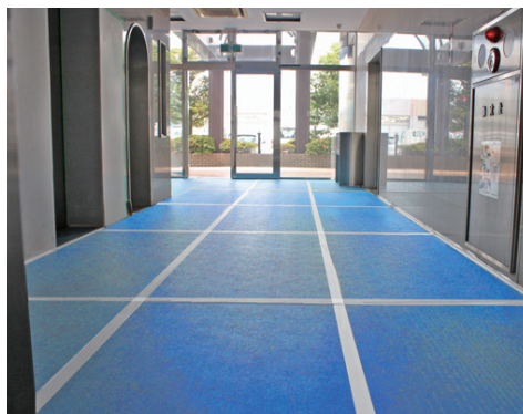
養生シート設置例
