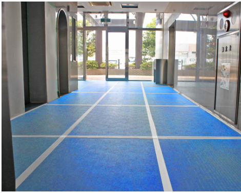
養生シート設置例
